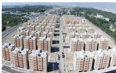
شکل ۲۱: مجتمع مسکونی با چندین بلوک ساختمانی
